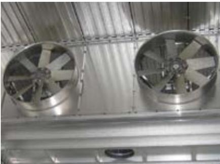
Система вентиляции состоит из реверсивных вентиляторов с 8 лопастями диаметром 800мм или 900мм и двигателей (NERI MOTORI Италия) в тропическом исполнении класс защиты IP 55, мощностью от 3кВт до 5,5кВт, количество и мощность вентиляторов рассчитываются для каждой камеры индивидуально, в зависимости от объема камеры.
