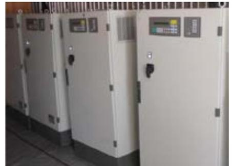
Каждая камера фирмы INCOPLAN оснащается индивидуальным электрошкафом, выполненным в полном соответствии с нормативами CE (Европейский стандарт). В электрошкаф монтируется блок электронного управления (контроллер) с системой ручного управления всеми агрегатами камеры, контроллер позволяет осуществлять процесс сушки в **полностью автоматическом режиме**. Выбор необходимой программы осуществляется оператором из библиотеки программ, где содержатся программы практически на любую породу древесины.
