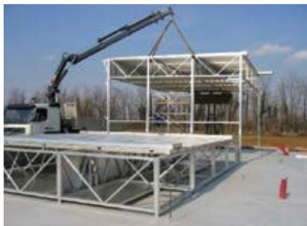
Структура сушильных камер Incoplan является поливалентной, т.к. построена на основе типовых стандартных элементов, которые используются во всей гамме камер для сушки и пропаривания. Использование таких элементов значительно сокращает сроки производства и монтажа камер.
