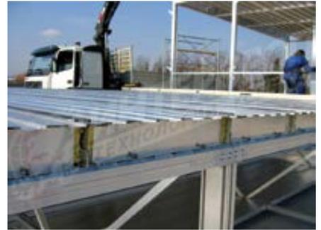
Наружные и внутренние листы стеновых панелей выполнены из гофрированного алюминия толщиной 0,6 мм, сплав EN AW 3105 с добавлением титана. Использование этих материалов гарантирует долгий срок службы даже в контакте с агрессивной средой. Утеплитель - стекловолокно, обработанное специальным связующим составом на основе термореактивных смол. Базовая толщина 100 мм. Удельный вес 30 кг/м<sup>3</sup>. Коэффициент теплопередачи утеплителя составляет 0,34 ккал/м<sup>2</sup>°С.
